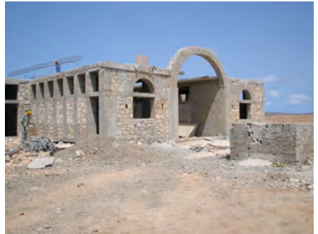
Centre de formation en construction à Vila Do Maio
