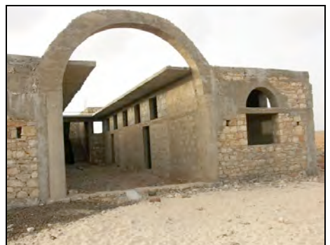
Entrée du CFPM
